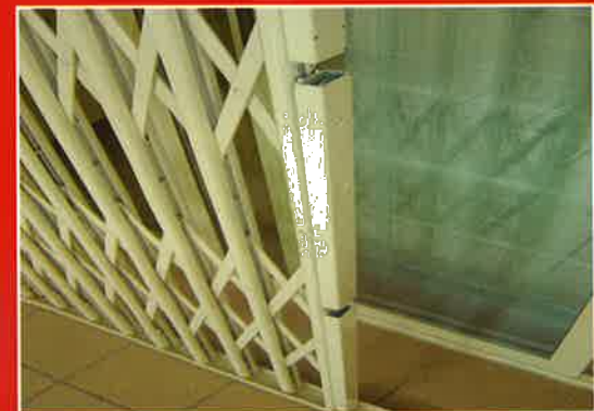
Detalle cierre 2 puntos / Double point lock Double système de fermeture
